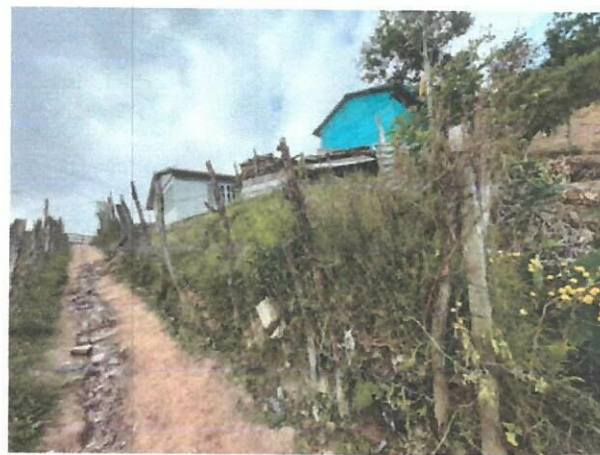
Foto 2: Se realizará instalación de muro perimetral con tubo y malla en el lado este del establecimiento, específicamente en el lado del callejón.
